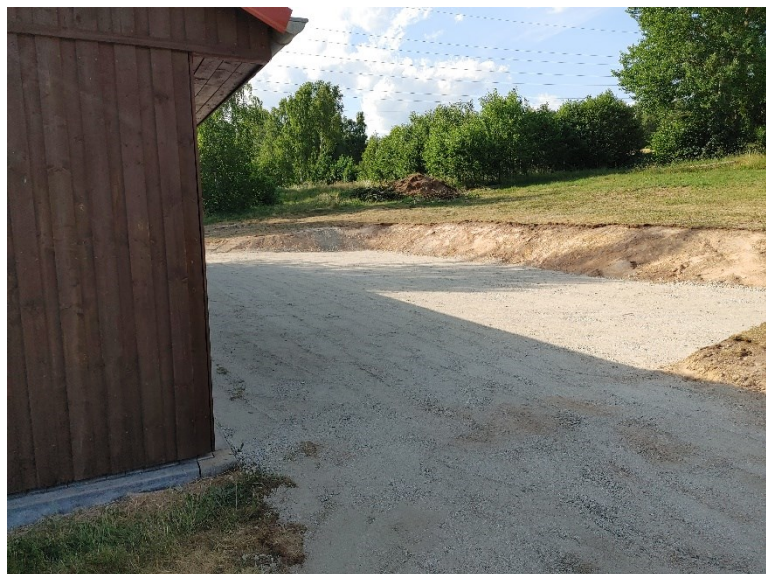
Po dokončení úprav
