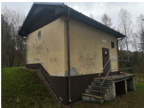
Fotografie vodárny před opravou
