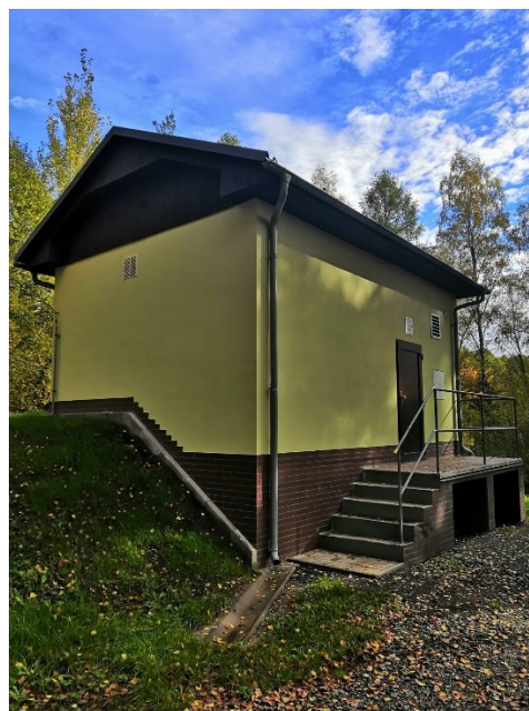
Fotografie vodárny po opravě
