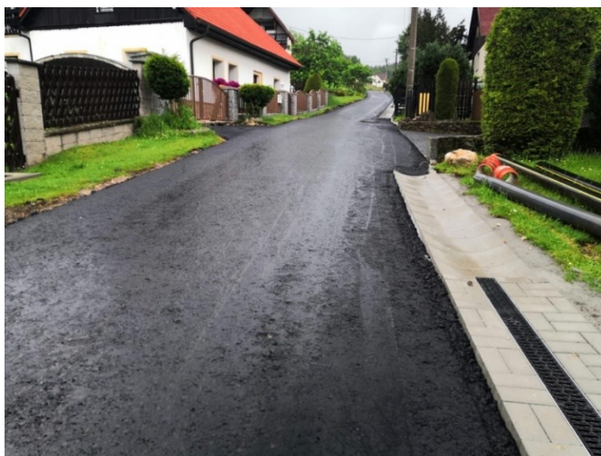
Oprava komunikace „Pod zastávkou“ – po rekonstrukci
