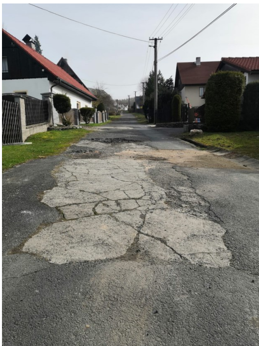
Oprava komunikace „Pod zastávkou“ – před rekonstrukcí
