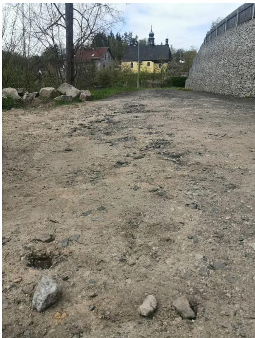
Oprava komunikace u hřbitova – před rekonstrukcí
