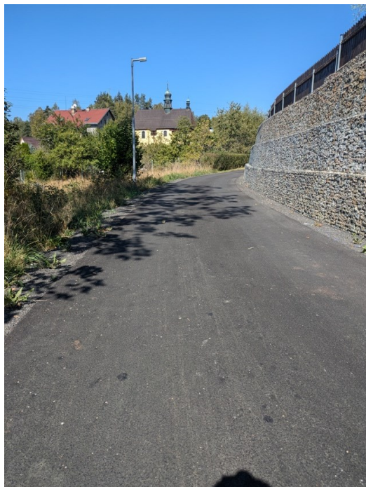
Oprava komunikace u hřbitova – po rekonstrukci
