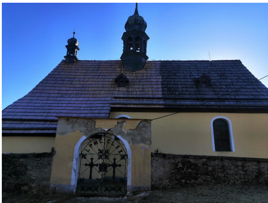
Oprava střechy kostela
