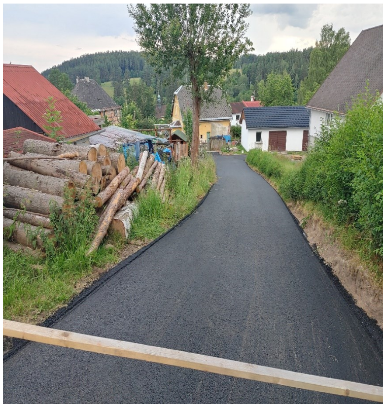
Mezi č. p. 12 a č. p. 13 po rekonstrukci
