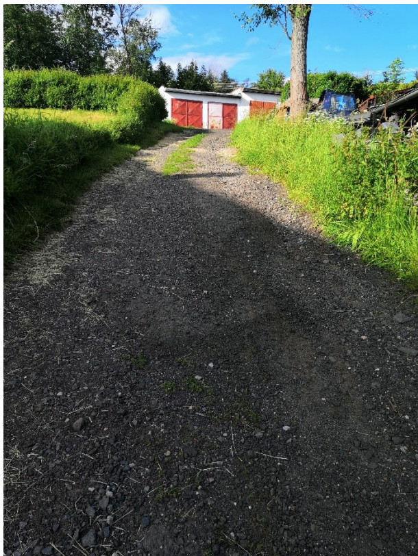
Mezi č. p. 12 a č. p. 13 před rekonstrukcí
