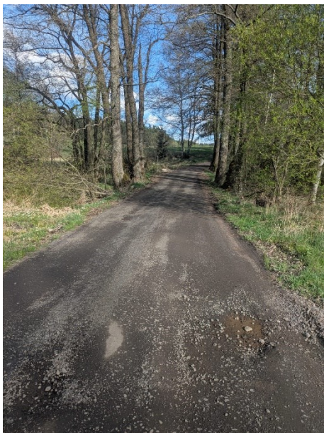
Oprava komunikace Spomyšl – před rekonstrukcí
