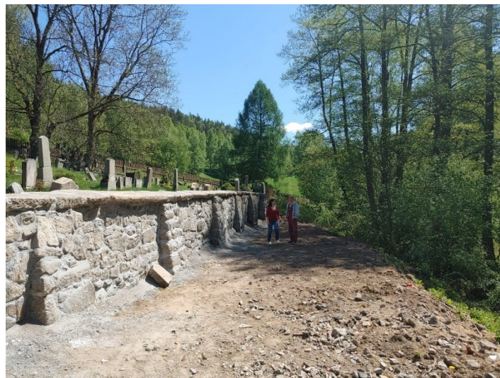
Oprava hřbitovní zdi – po rekonstrukci
