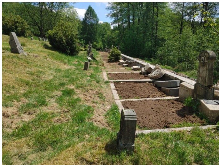
Část hřbitova – po rekonstrukci
