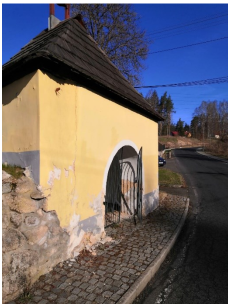
Oprava kaple – před rekonstrukcí
