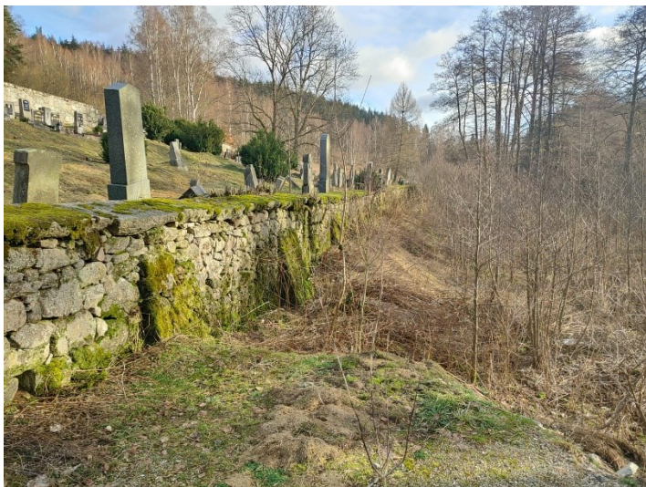
Oprava hřbitovní zdi – před rekonstrukcí
