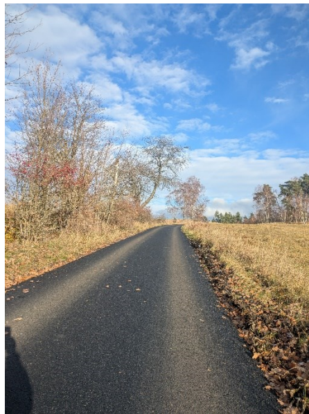
Oprava komunikace Křemenitá – po rekonstrukci
