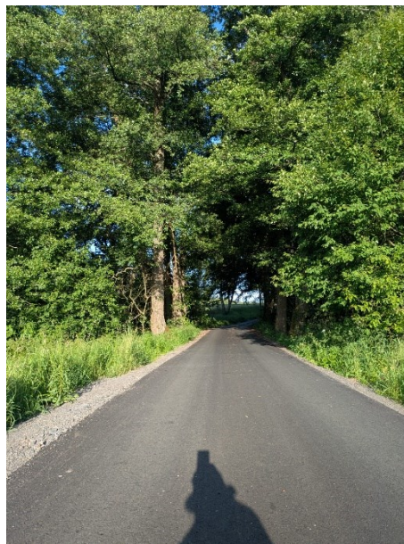
Oprava komunikace Spomyšl – po rekonstrukci
